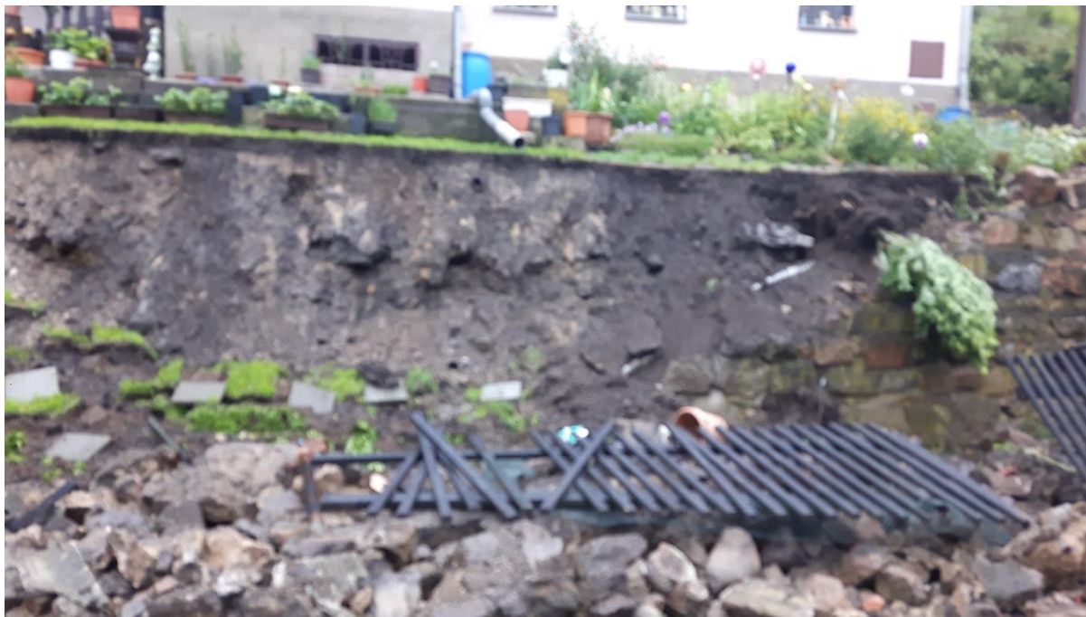
Obrázek 2 - Odvodnění povrchu za rubem opěrné zdi
