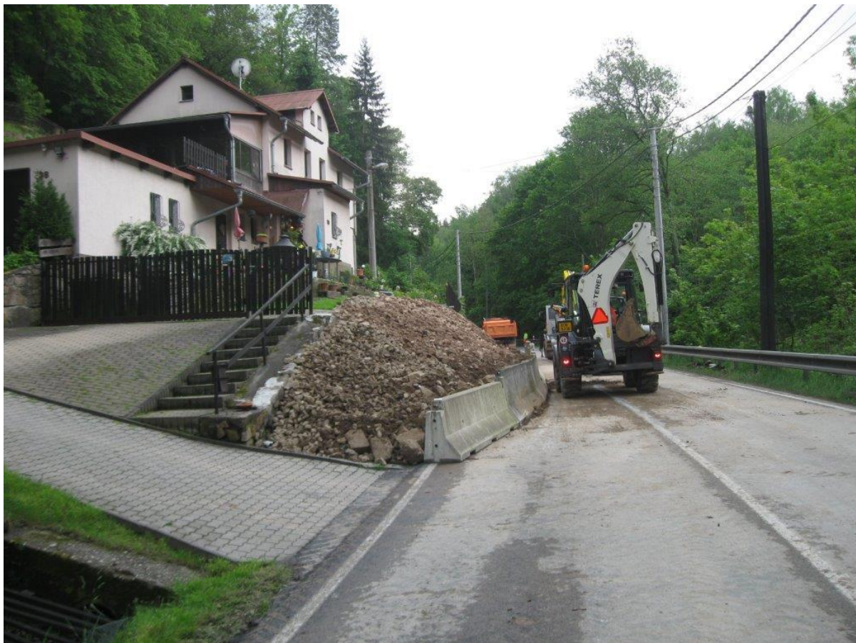
Obrázek 3 - Provedená přitěžovací lavice
